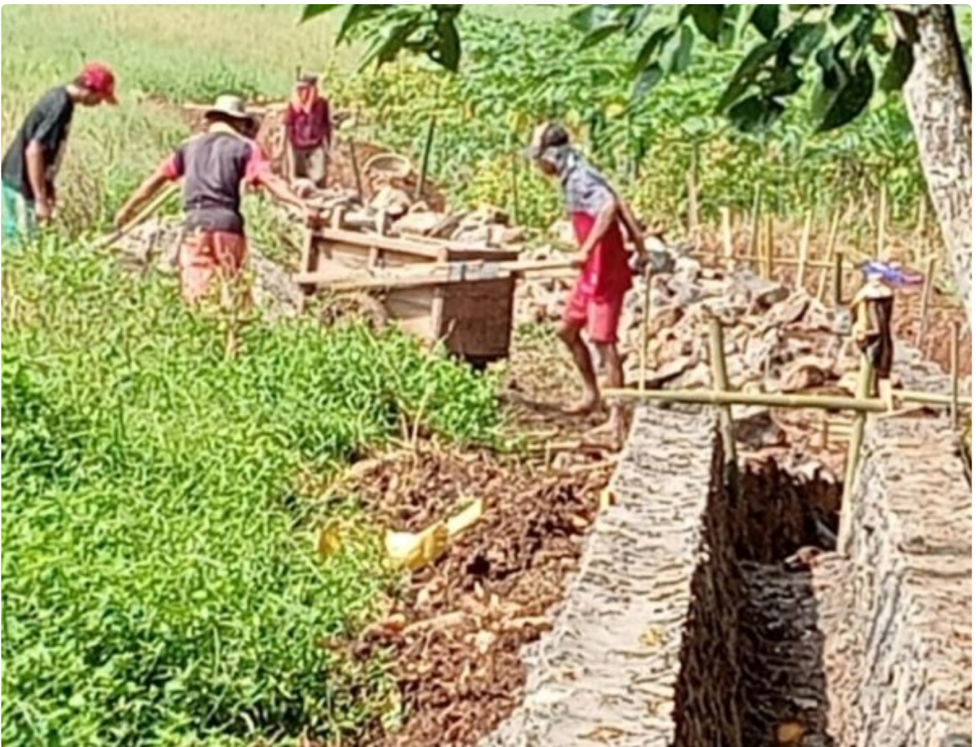
Warga Desa Banyubiru Kecamatan Labuan Bangun Drainase
